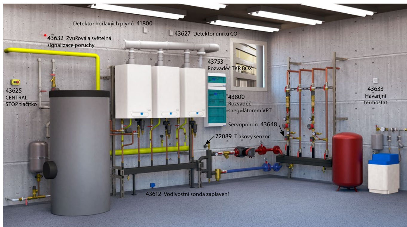
Příklad využití regulátoru THERM VPT/R v kotelně
