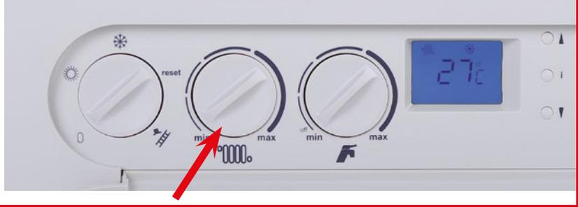
Z výše uvedeného vyplývá, že točítkem pro nastavení teploty topení na ovládacím panelu se v tomto režimu kotle nepřímo nastavuje požadovaná teplota vytápěcího prostoru. Počátečně (výrobně) je nastavena ekvitermní křivka „K“ = 1,6. Výchozí uživatelské nastavení otočného ovladače teploty topení je doprostřed nastavovací dráhy (ukazatel nahoru, což odpovídá posuvu křivky  $0^\circ\text{C}$ ).
