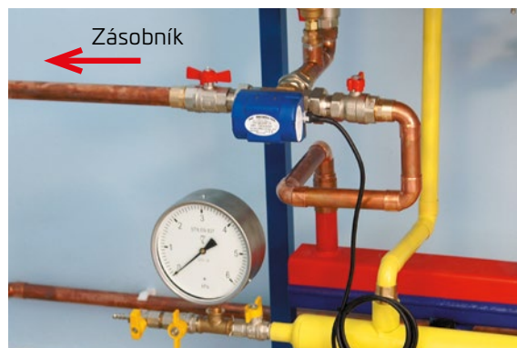
Připojení zásobníku TV ke kotli
